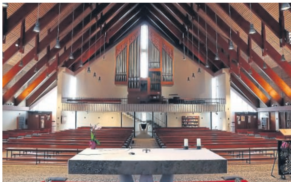
Das Innere der Kirche St. Petrus und Paulus zeichnet sich durch die auffällige Binderkonstruktion unter dem Dach aus.
