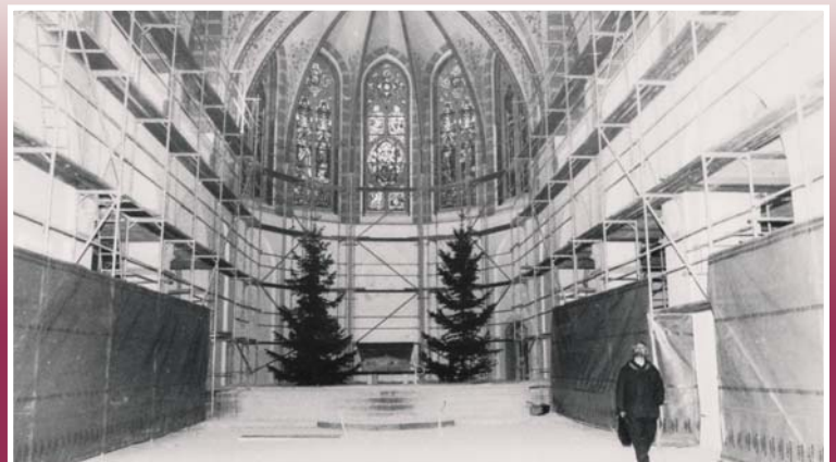
Renovierung, Weihnachten 1990 in der „Baustelle“
